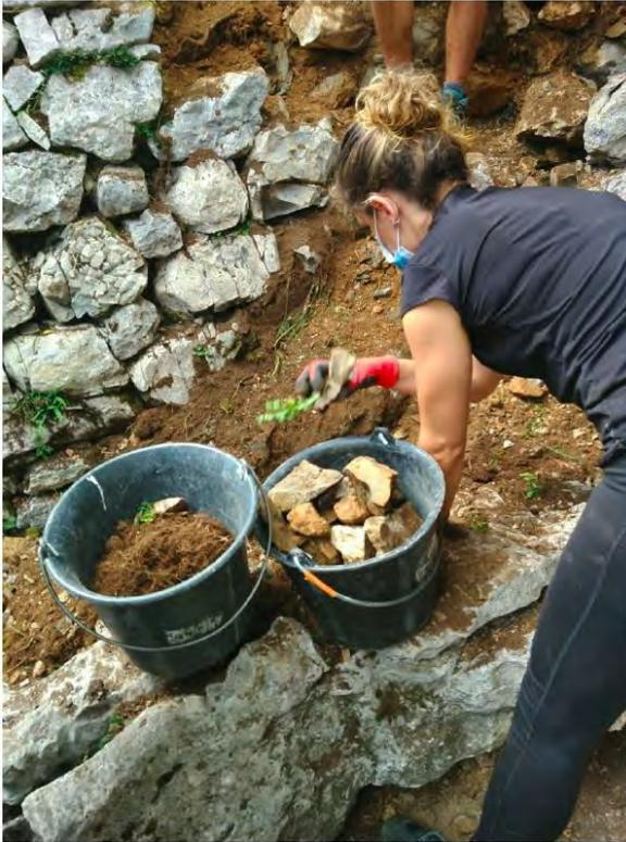
→ LES MURS DE SOUTÈNEMENT, UNE FOIS LES PARTIES FRAGILES DÉMONTÉES, ONT ÉTÉ PURGÉS SUR 70CM DE PROFONDEUR DE LA TERRE D'INFILTRATION (ICI PARTIE SUD DU MUR)
