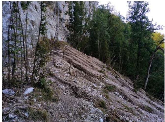
Chutes de pierres sur le chemin menant au pas de l'Allier
