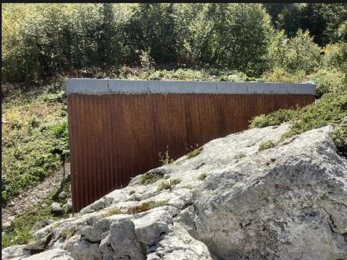
*Si l'on monte au dessus de la baraque des clos, on peut vérifier que le rocher protège efficacement la cabane, la couverture en tôle ondulée au fil des années s'est oxydée,*
