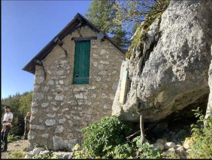
*Pignon que l'on aperçoit quand on vient depuis Prélénfrey, l'ouverture donne sur l'étage, on y accède par des barreaux scellés directement dans la maçonnerie de pierre. Cette ouverture permet à la fois un accès en hiver en cas de forte chute de neige, mais aussi de sortie accessoire de secours depuis l'étage.*
