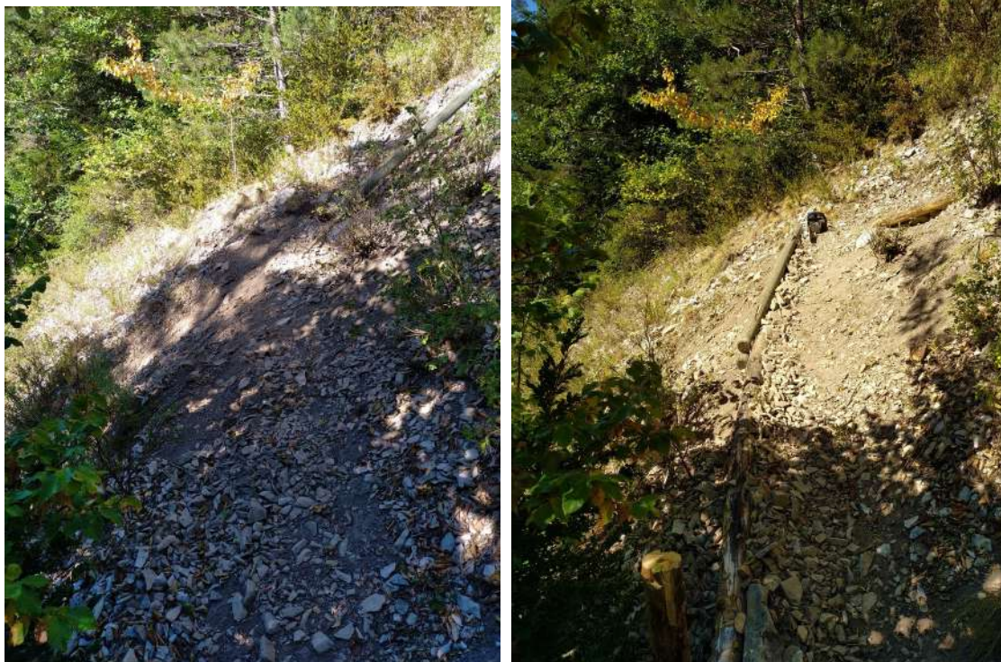
Avant, après : reprise du sentier
