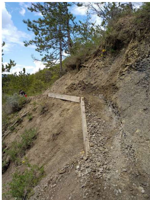
Stabilisation d'une portion du sentier
